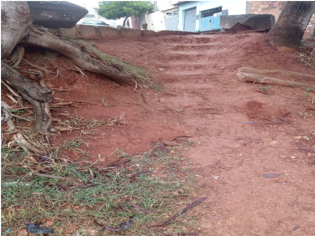
Escada improvisada pelos moradores
