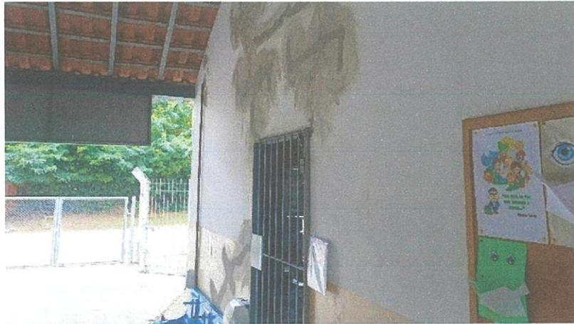
EMEF Aparecida Sallum – Pintura desgastada e inexistência de equipamentos de combate a incêndio
