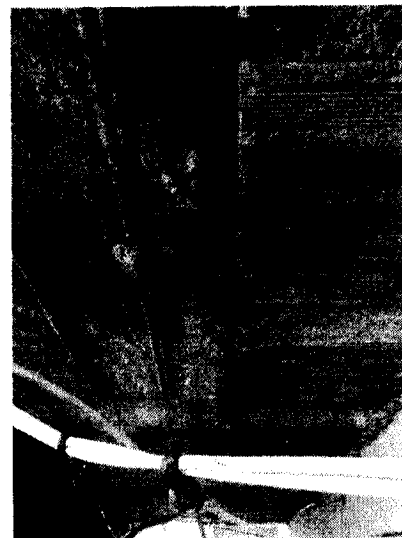
Foto 6- Armação de ferro aparente e com ferrugem
