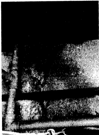
Foto 9- Viga de concreto trincada.
