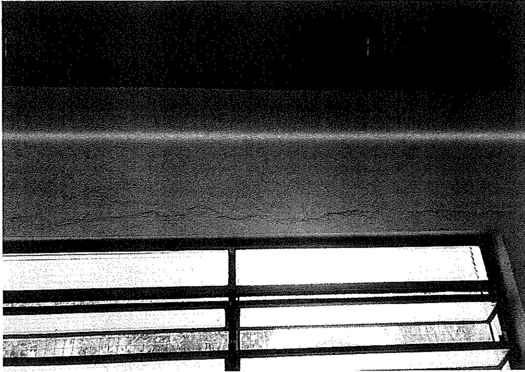
**Parede da cozinha com rachadura e sinais de umidade;**
