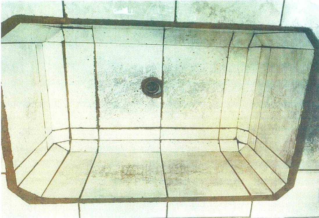
**Pia com azulejos trincados e com tintura descascada;**
