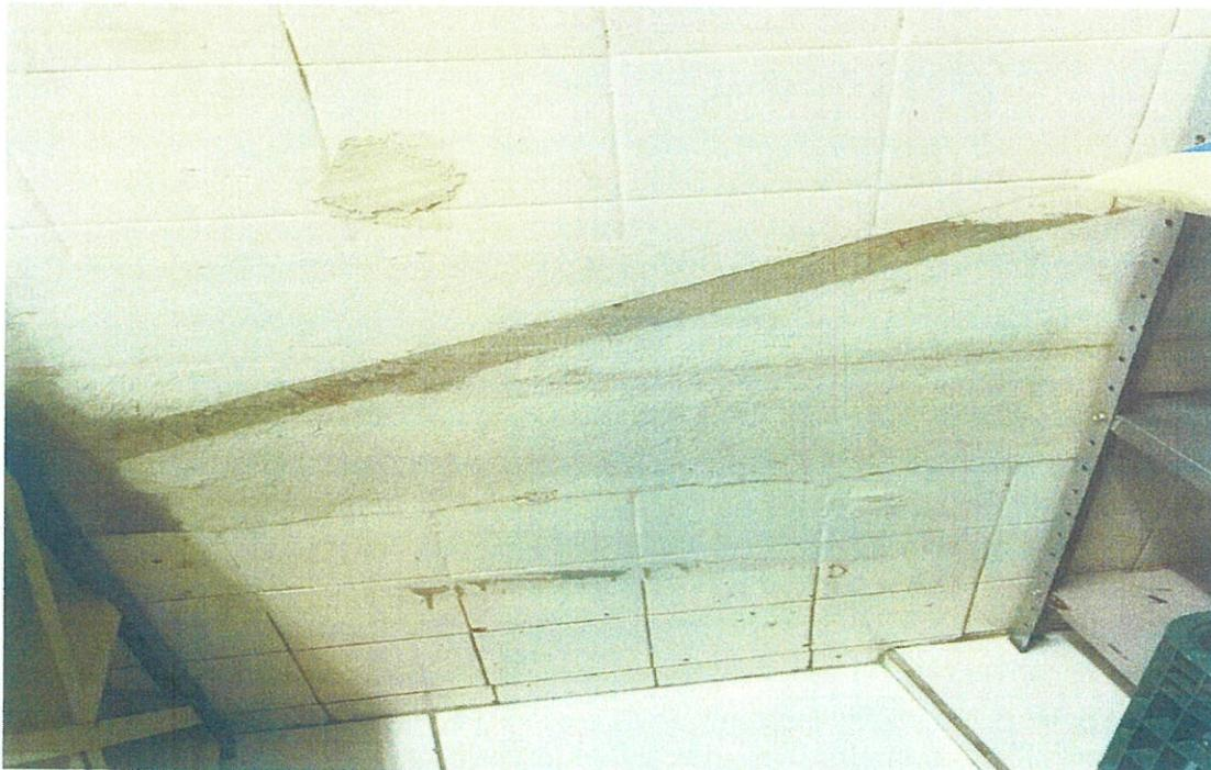
**Parede do estoque com cimento e tinta branca em cima dos azulejos;**
