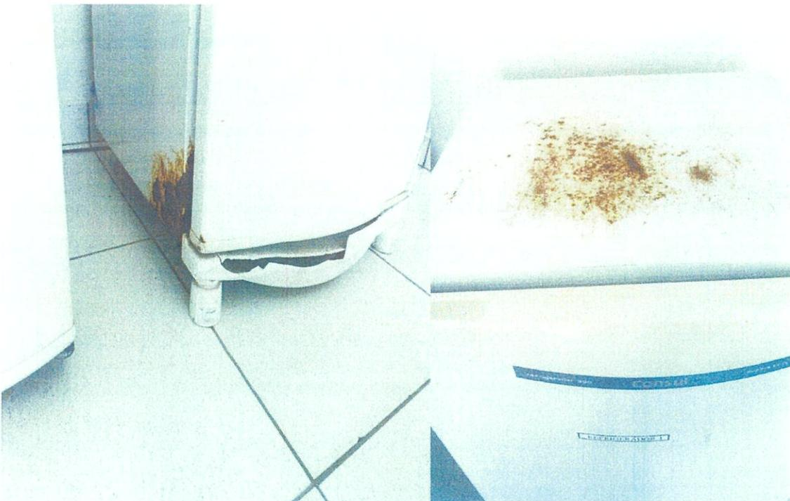
**Equipamento quebrado na parte inferior e com sinais de ferrugem tanto na parte inferior quanto na superior;**
