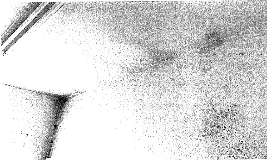
**Teto do estoque com sinais de umidade transcorrendo às paredes;**
