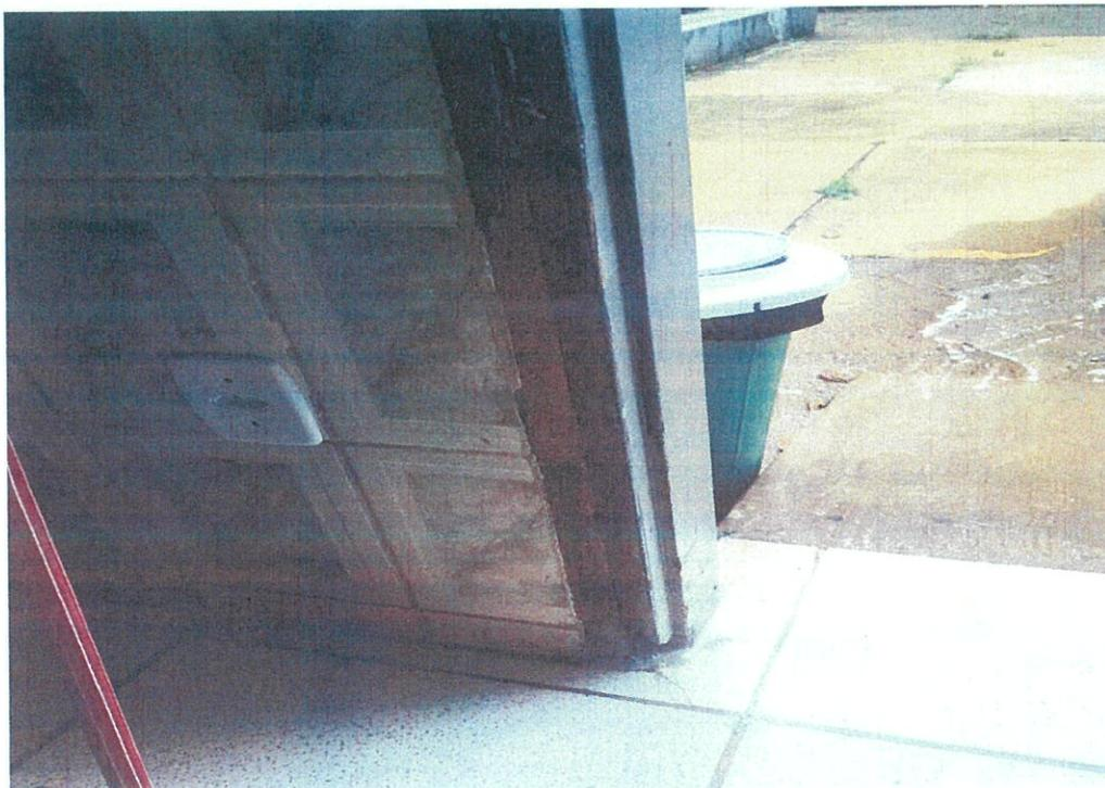
**Batente da porta de entrada da cozinha com madeira retirada e quebrada;**
