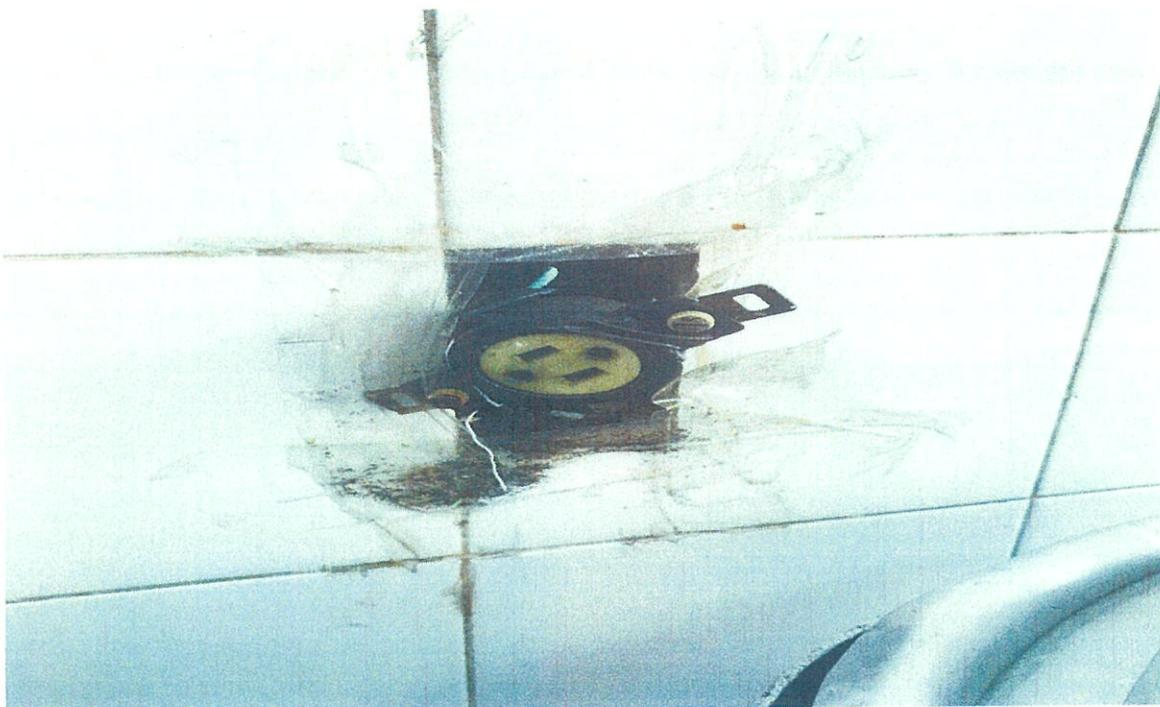
**Tomada atrás do fogão com buraco aberto na parede e com material colante próximo ao buraco, com risco de cair nos alimentos preparados;**
