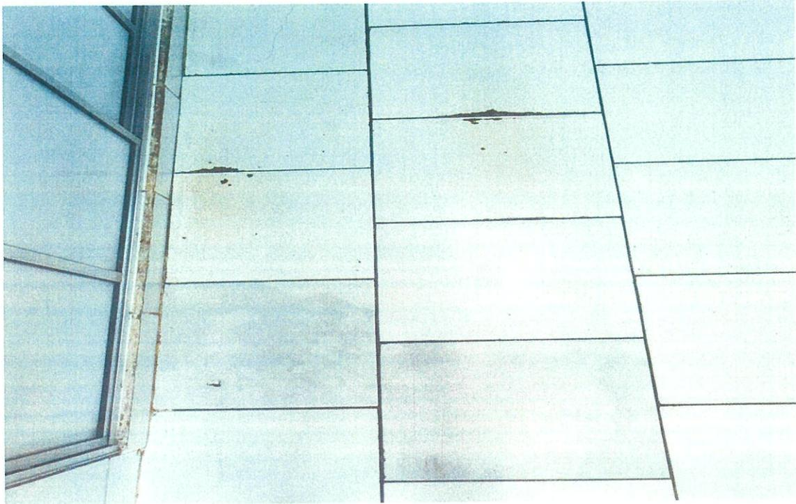
**Piso da cozinha com rachadura e sinais de umidade;**
