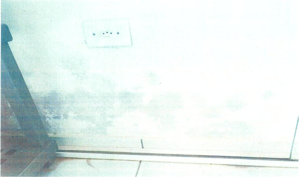
**Parede do estoque com sinais de umidade;**
