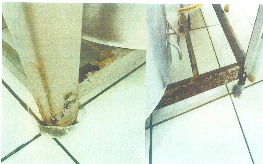
**Parte inferior do equipamento (fogão) com ferrugem;**
